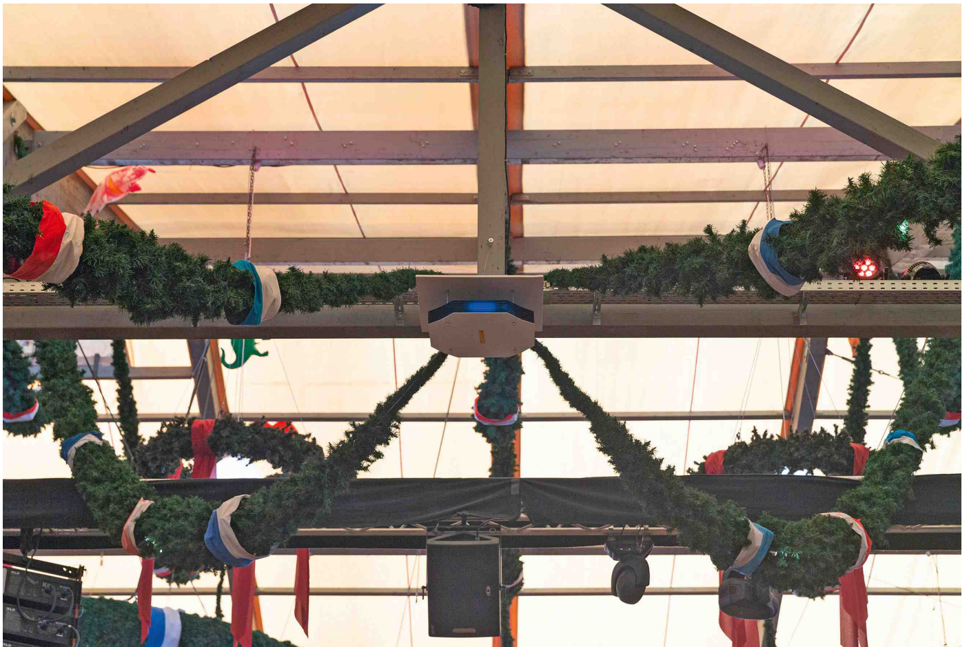
UVC-Gerät in der Festhalle auf dem diesjährigen Oktoberfest. Die UVC-Technologie ist eine gängige Desinfektionsmethode, u.a. in der Lebensmittelproduktion, in der Wasserentkeimung oder im Medizinbereich. Bild: Festhalle Schottenhamel / K. Jungblut
