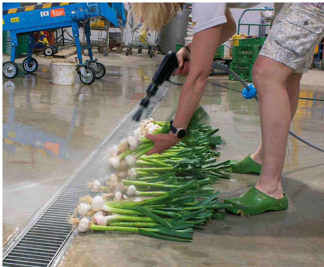
Die Grobschmutz-Wanne von Aschl kann noch mehr Feststoffe und Pflanzenreste fassen: Die quadratische Bodenwanne mit begehbarem Gitterrost punktet mit ihrem sehr großen Schmutzfangkorb mit bis zu 14 Liter Volumen.
