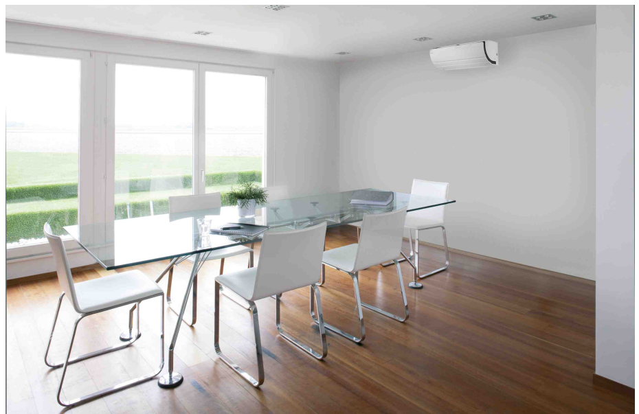
Bild 3: Bei Raumklimageräten in Split- und Multi-Split-Ausführung ist die Leistungsregelung mit Inverter inzwischen Standard. Sie arbeiten hocheffizient. Bild: Bart Van Leuven/Daikin
