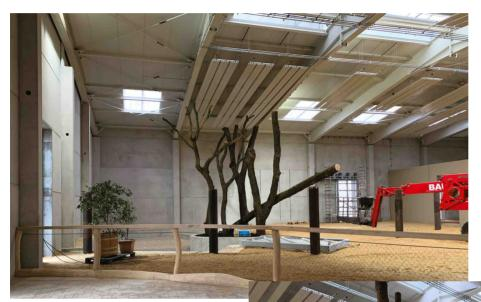
ten. Das eingesetzte System KIT der RMBH GmbH punktet mit geringem Gewicht, modularem Aufbau und hoher Wärmeabgabe bei kleiner Fläche.
