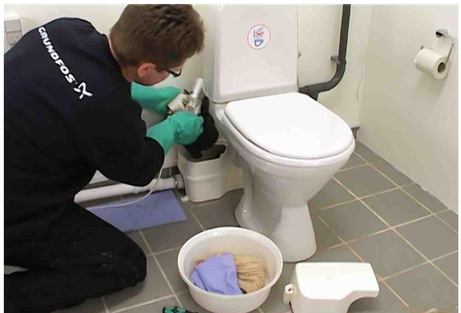
Bei der Wartung der „Sololift2“-Schwarzwassermodelle von Grundfos muss der Fachhandwerker weder die gesamte Installation demontieren noch in die Anlage hineinfassen.
