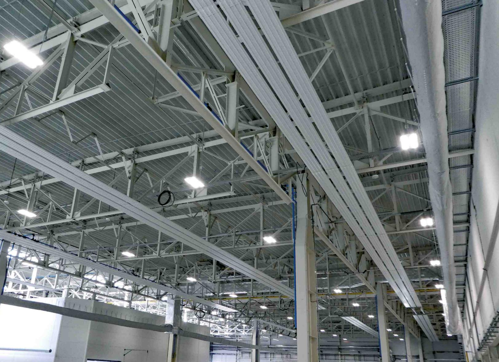
Eine Industriehalle wird mit der Deckenstrahlplatte KIT Classic ausgestattet, hier die Variante in 1.100 mm Breite aus drei Platten.
