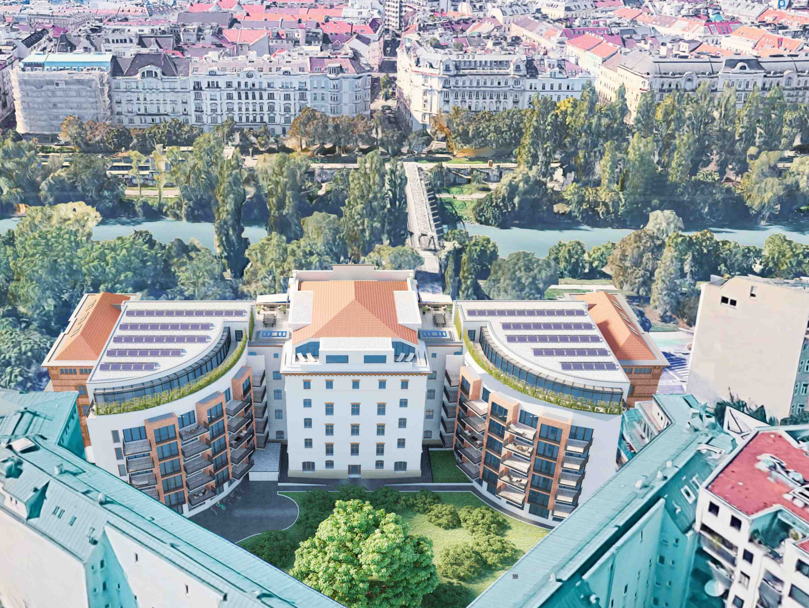
Die Hoffassade des Wohnprojekts Das Artmann.
