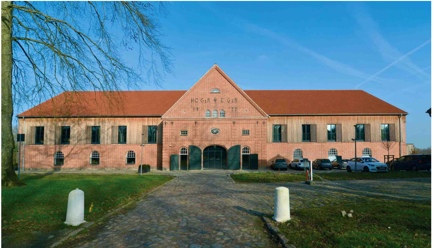
Im historischen Stallgebäude befindet sich der Empfang des Golfhotels Breitenburg.
