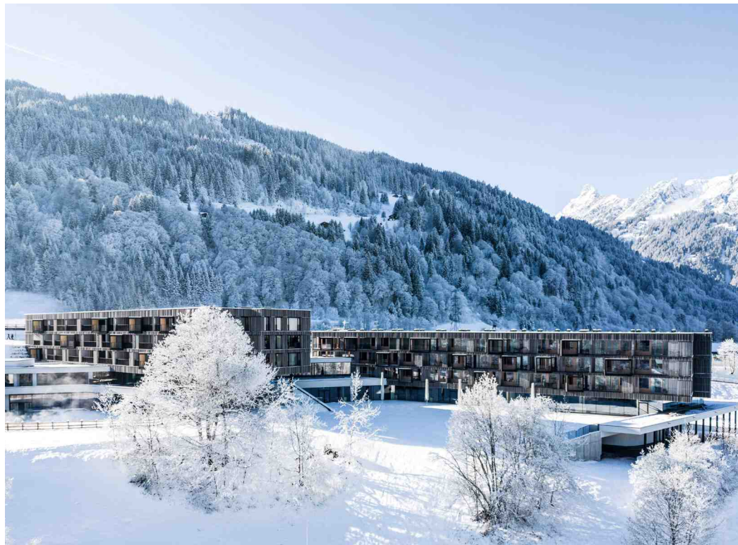
Das Falkensteiner Montafon besteht aus zwei Baukörpern, die sich um einen zentralen Kern mit den Gemeinschaftsbereichen gruppieren. Bild: Falkensteiner
