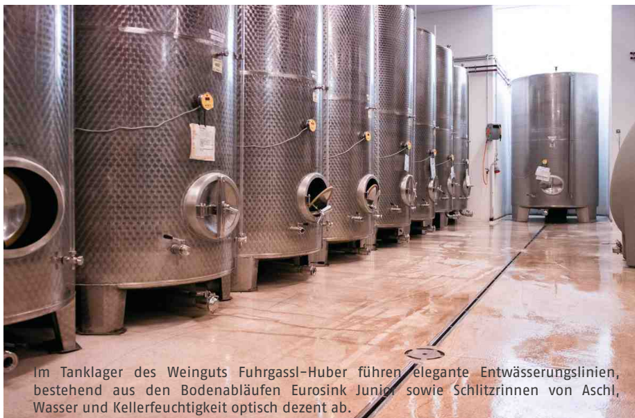
Im Gewölbekeller punkten die Edelstahl-Bodenabläufe Eurosink Junior von Aschl mit ihrer tottraumfreien Hygieneform. Die glatte Oberfläche verhindert, dass sich Schmutzreste und Keime festsetzen können.
