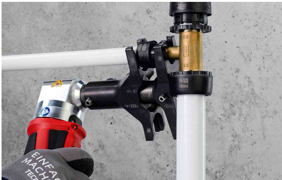
TECE favorisiert die axiale Verpressung. Der Anbieter sieht darin besondere Vorteile in der sicheren Verbindung. Bild: TECE
