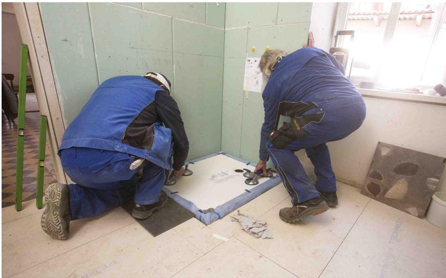
Im Duschbereich wurde die bodenebene Duschrfläche Geberit Olona eingebaut, die die höchste Rutschhemmklasse C aufweist.
