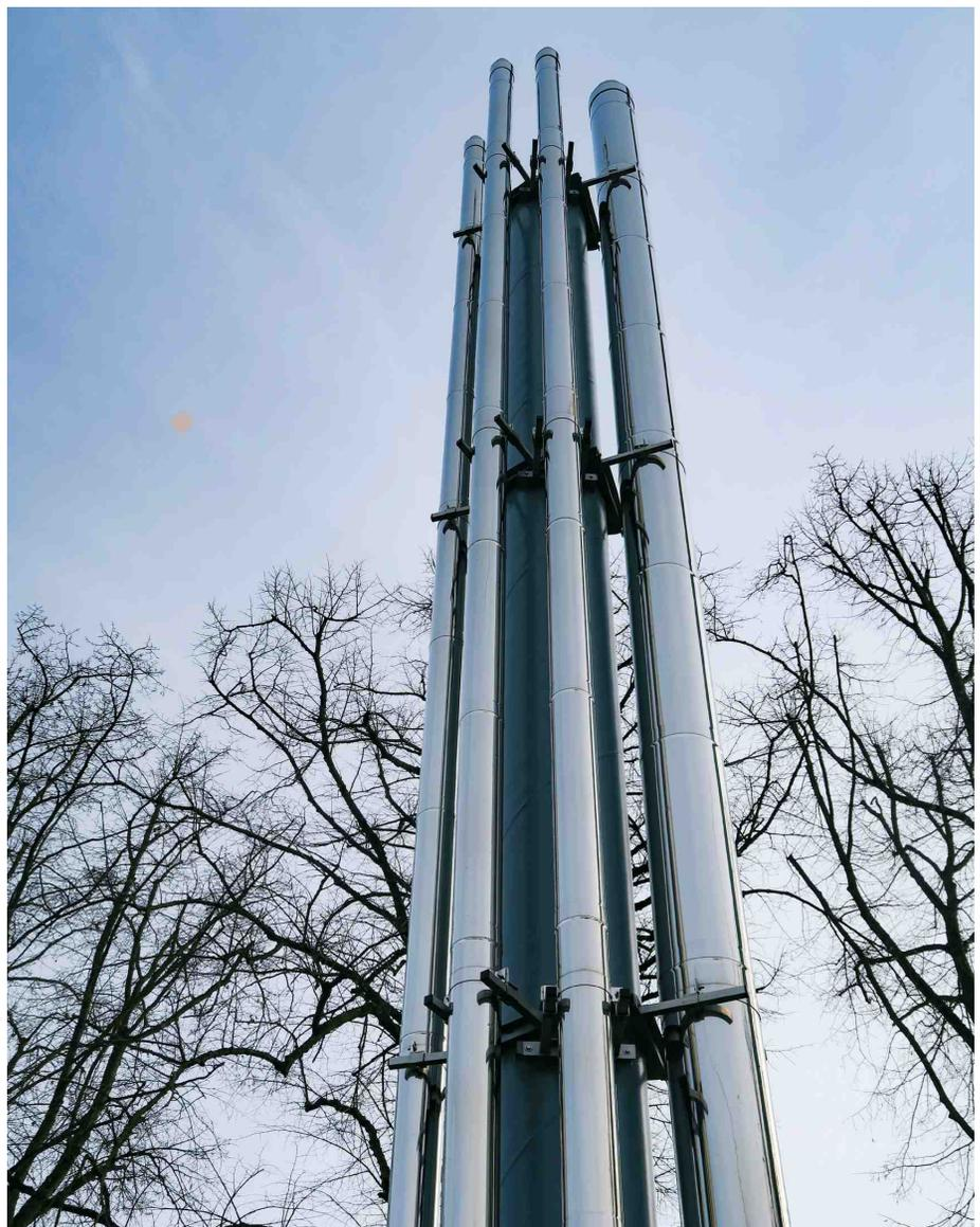
Imposant: Die frei stehende Abgasanlage mit vier Leitungen misst etwa 12 m in der Höhe.
