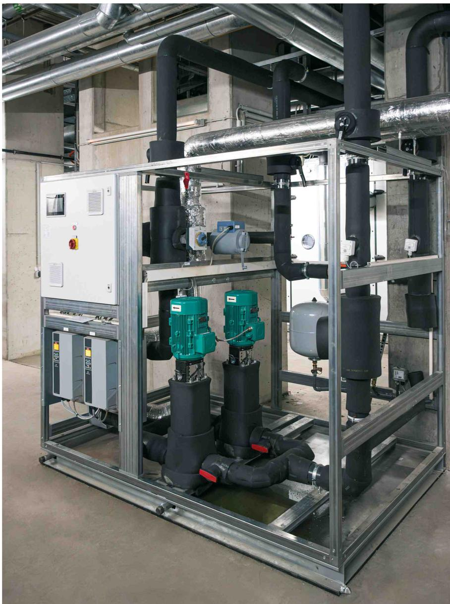
EcoCond in Vollversion: Die Wärmerückgewinnung hat nach der Sanierung einen Wirkungsgrad von mindestens 69 Prozent.
