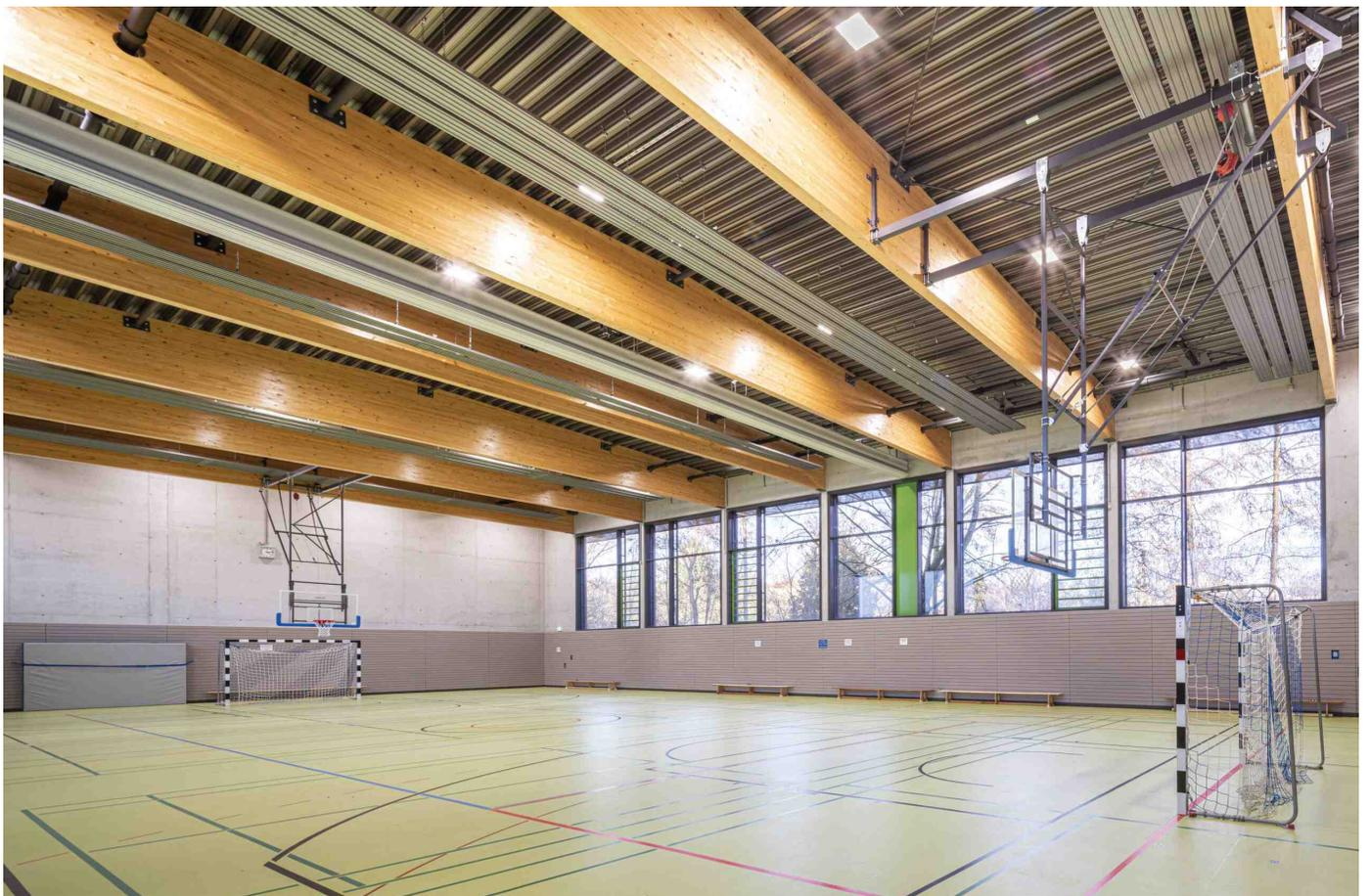
Für die Neubauhalle griff man auf Deckenstrahlplatten Zehnder ZIP zurück, von denen sechs Bänder mit einer Länge von je 16 m und mit Breiten von 704 und 1088 mm installiert wurden. Das entspricht einer Fläche von 82 m<sup>2</sup>.
