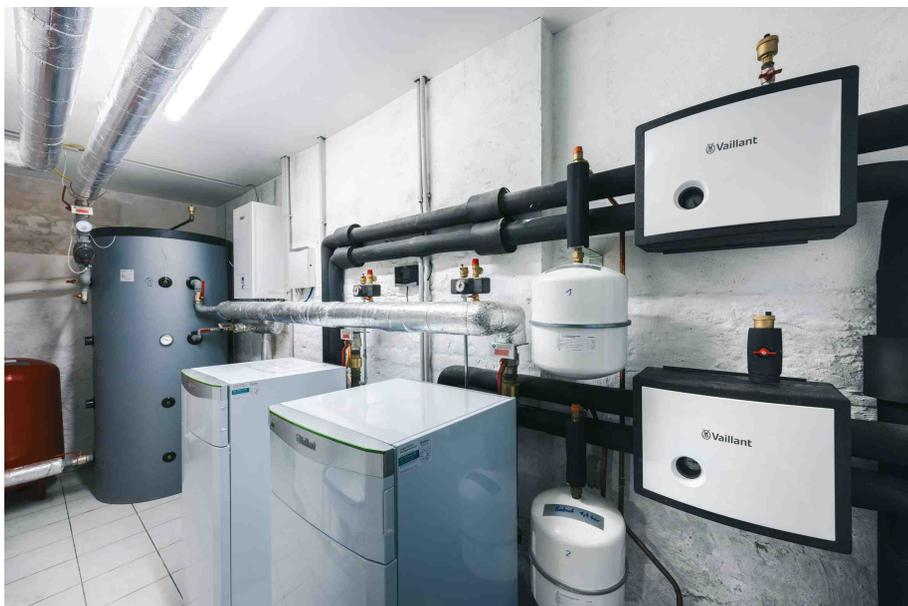
Nach der Altbausanierung verfügt das Wohnhaus in der Prechtlgasse über ein neues Heizsystem, bestehend aus einer Vaillant Luft-Wärmepumpen-Kaskade. Für das Warmwasser wurden E-Boiler in den Wohneinheiten installiert, die mit Strom aus der PV-Anlage am Dach versorgt werden.
