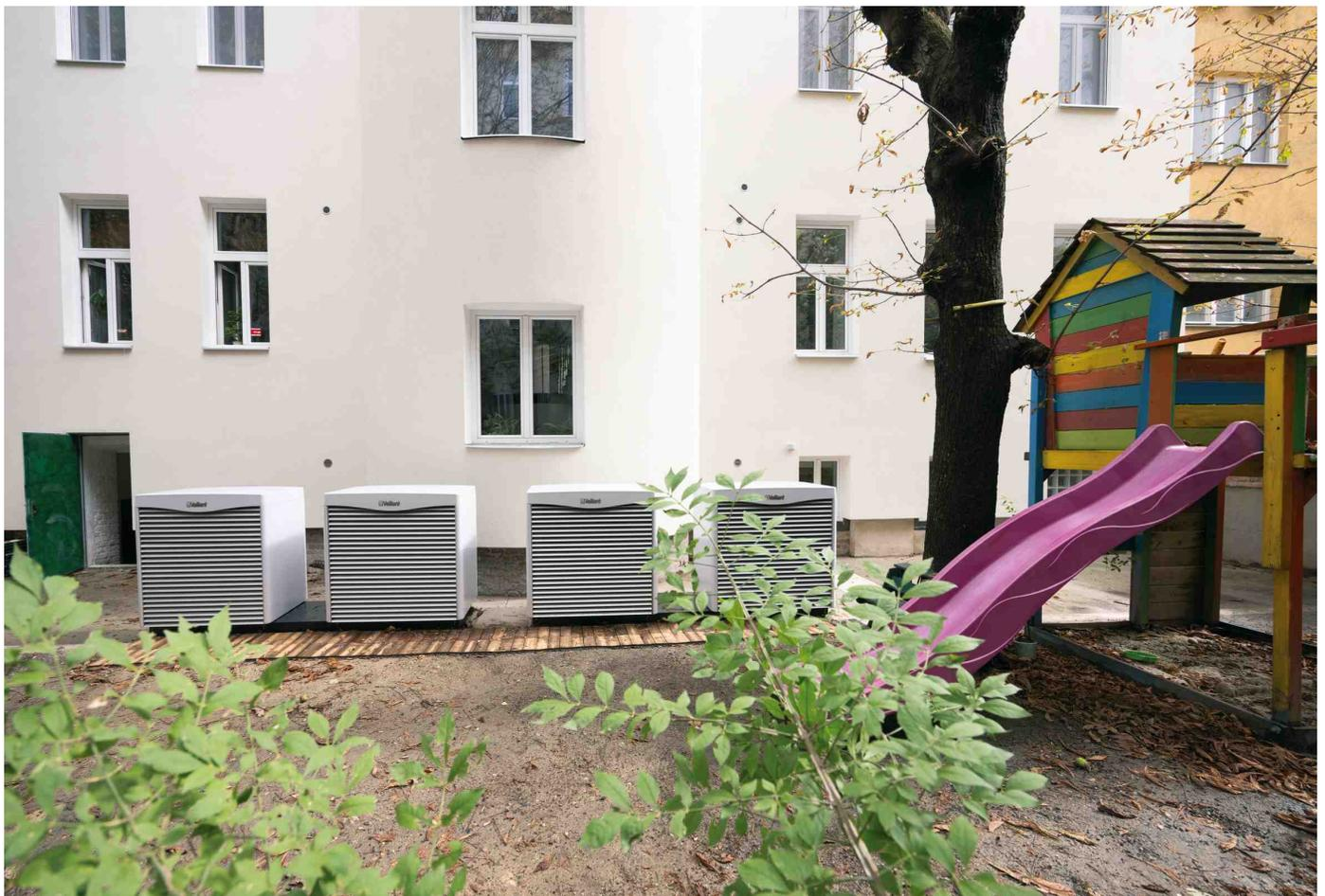
Die kaskadierten Vaillant aroCOLLECT Außengeräte im Innenhof sind bei voller Leistungsstärke besonders geräuscharm. Außerdem erfüllen sie die Kriterien der Spielplatznorm. Die Anbringung in unmittelbarer Nähe zum Technik Keller gestaltete den Anschluss besonders einfach und effizient.
