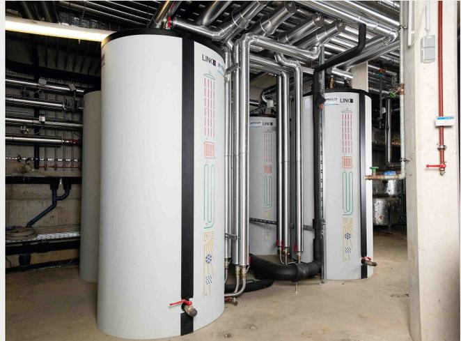
Nach dem Umbau der Anlage stellen vier Powerlink-Speicher die hygienegerechte Versorgung der großen Anlage sicher.
