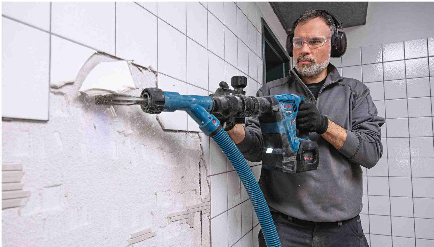
Die Sicherheit und Gesundheit der Mitarbeiter liegt den Unternehmen sehr am Herzen. Bosch Power Tools bietet eine Reihe von Features, die dafür sorgen. Hier im Bild zum Beispiel das Click & Clean System, das staubfreies Arbeiten ermöglicht.
