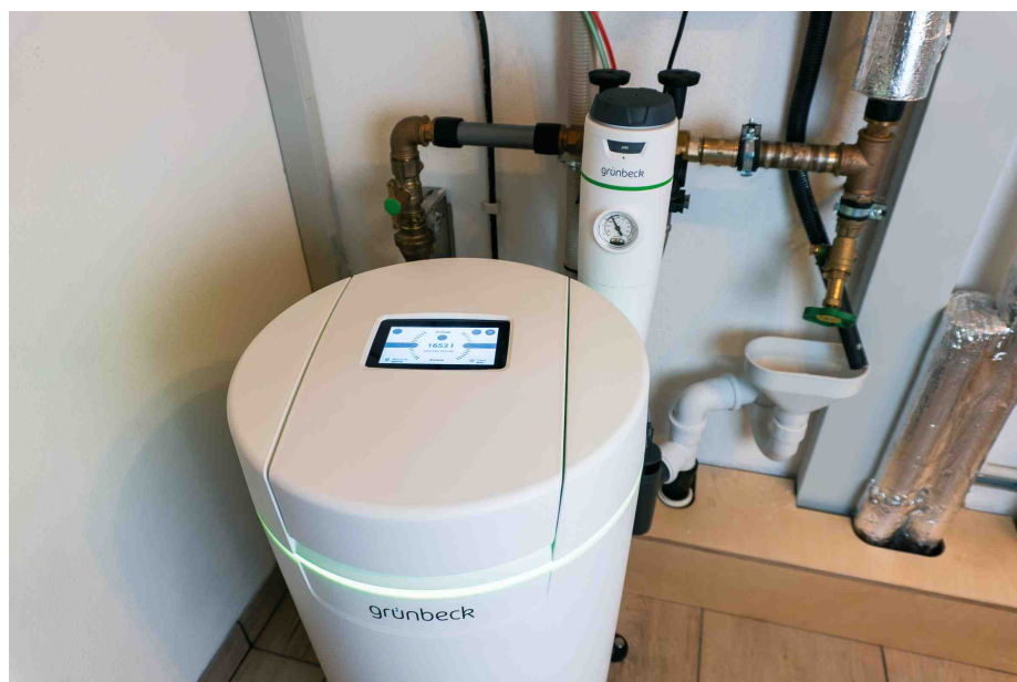
Wo bei Familie Gutmair vorher nur ein Grünbeck-Boxer-Filter verbaut war, befindet sich jetzt das cliQlock-Modulsystem samt Enthärtungsanlage und Filter mit Druckminderer.
