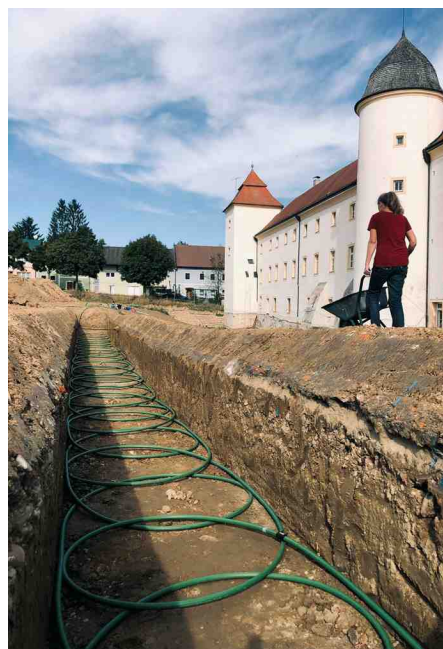
Im Schloss Losensteinleiten ist die Erdwärmequelle als Anergienetz mit RingGrabenKollektor ausgeführt.
