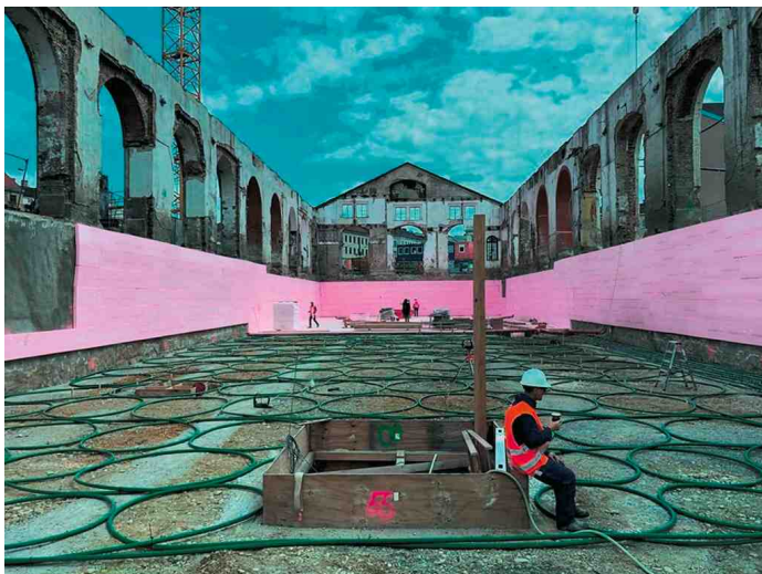
In der Gösserhalle wurde der RingGrabenKollektor ohne zusätzliche Erdarbeiten in der Sauberkeitsschicht vergossen.
