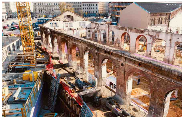
In der Gösserhalle wurde der RingGrabenKollektor ohne zusätzliche Erdarbeiten in der Sauberkeitsschicht vergossen.
