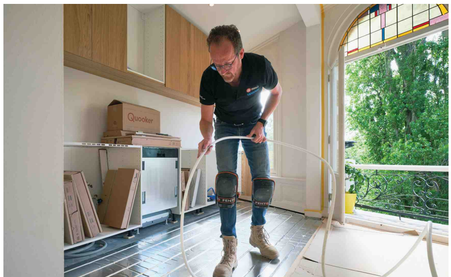
Ein Vorteil des Fußbodenheizungssystems ist die einfache Ein-Mann-Verlegung.
