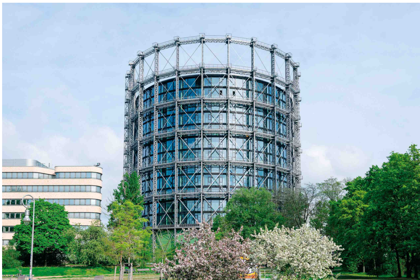
Der EUREF-Campus in Berlin zeichnet sich durch energieeffiziente Bauweisen, innovative Mobilitätslösungen wie E-Mobilität und Carsharing sowie nachhaltige Energienutzung aus.
