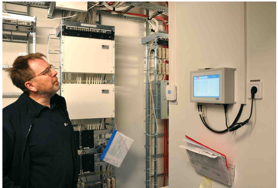
Die Master-Einheit des GF Hycleen Automation Systems ist mit dem zentralen Gebäudemanagementsystem verbunden. Ein Master kann bis zu 50 Ventile steuern-alle Komponenten werden bei der Installation automatisch erkannt.
