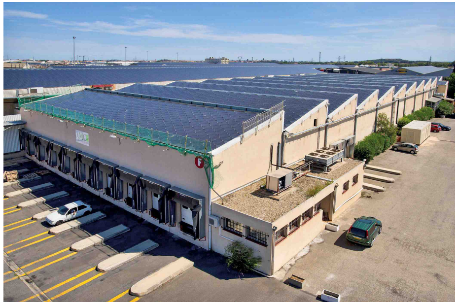
Durch den Einsatz der Solardachlösungen von Sunstyle werden jährlich 624t CO 2 -Emissionen bei diesem Logistikzentrum für Obst und Gemüse in Perpignan im Süden Frankreichs am Mittelmeer vermieden. Mit 97000 Solardachziegeln, einer Fläche von 70000m 2 und einem Jahresertrag von 10700000 kWh ist das Logistikzentrum ein leuchtendes Beispiel für BIPV.
