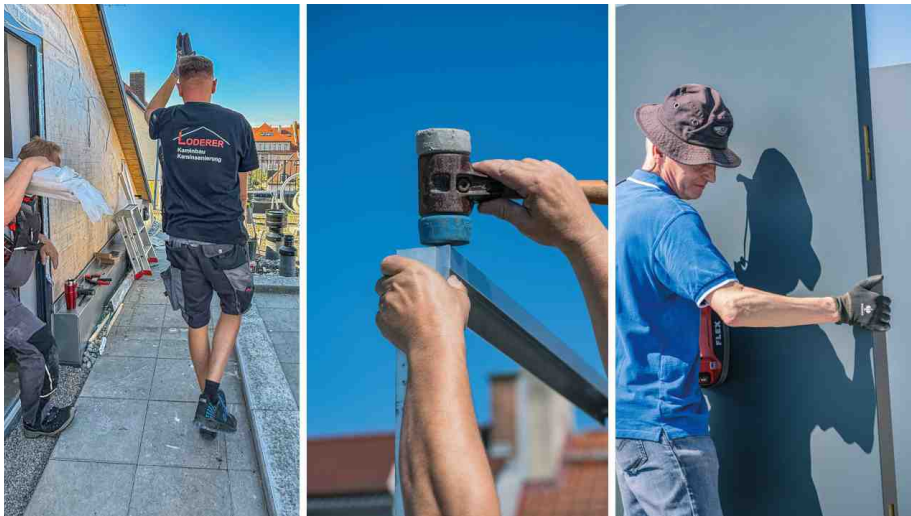
Alle Streben und Platten der Schallschutzumhausung sind so leicht, dass ein bis zwei Personen sie einfach zum Montageort tragen können.
