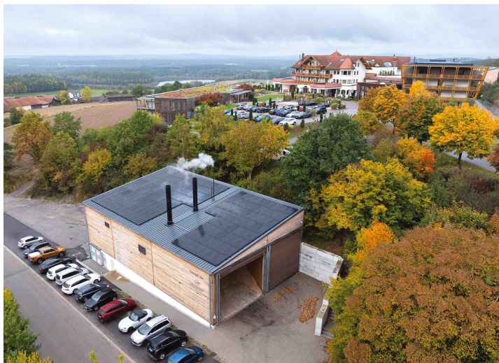
Das Heizhaus „EnergyCube“ des Birkenhofs. Hier befinden sich nicht nur die Hackschnitzelkessel, sondern auch ein Holzvergaser, mit dem zusätzlich Strom erzeugt wird.
